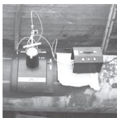
Kompaktiška detalė iš PE-HD, skirta tokiu vamzdžio pažeidimų, kaip subraizymų, jréžimų, kiauryminų pažeidimų remontui. Atvira kaitinimo spiralé optimaliam energijos perdavimui virinimo metu. Montavimui naudoti vaakuminę pompą VACUPUMP (užsakymo numeris 613 827). Su terminiu indikatoriumi vizualiai suvirinimo proceso kontrolei.
